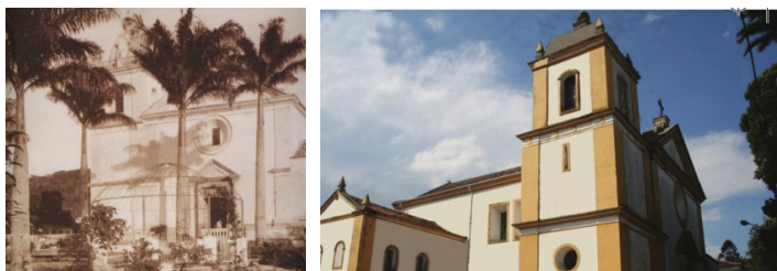
C6 Igreja Matriz de São José. (Decreto Estadual nº2.989) Rua: Padre Macário – Centro Histórico.
